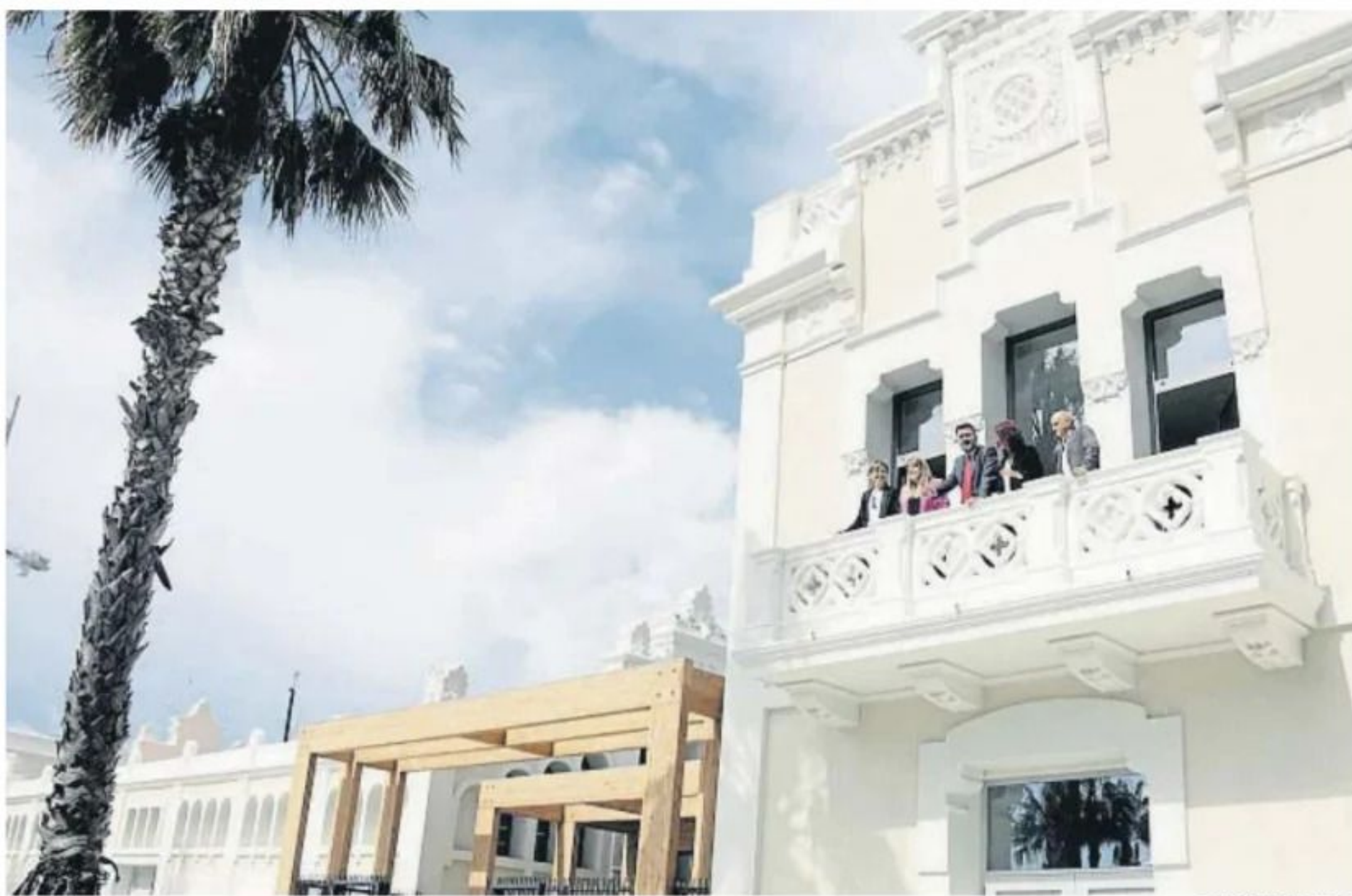
Imagen exterior de los edificios rehabilitados y de uno de los nuevos pórticos de madera que los unen
